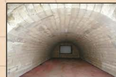
Volta refrattaria Refractory crown
